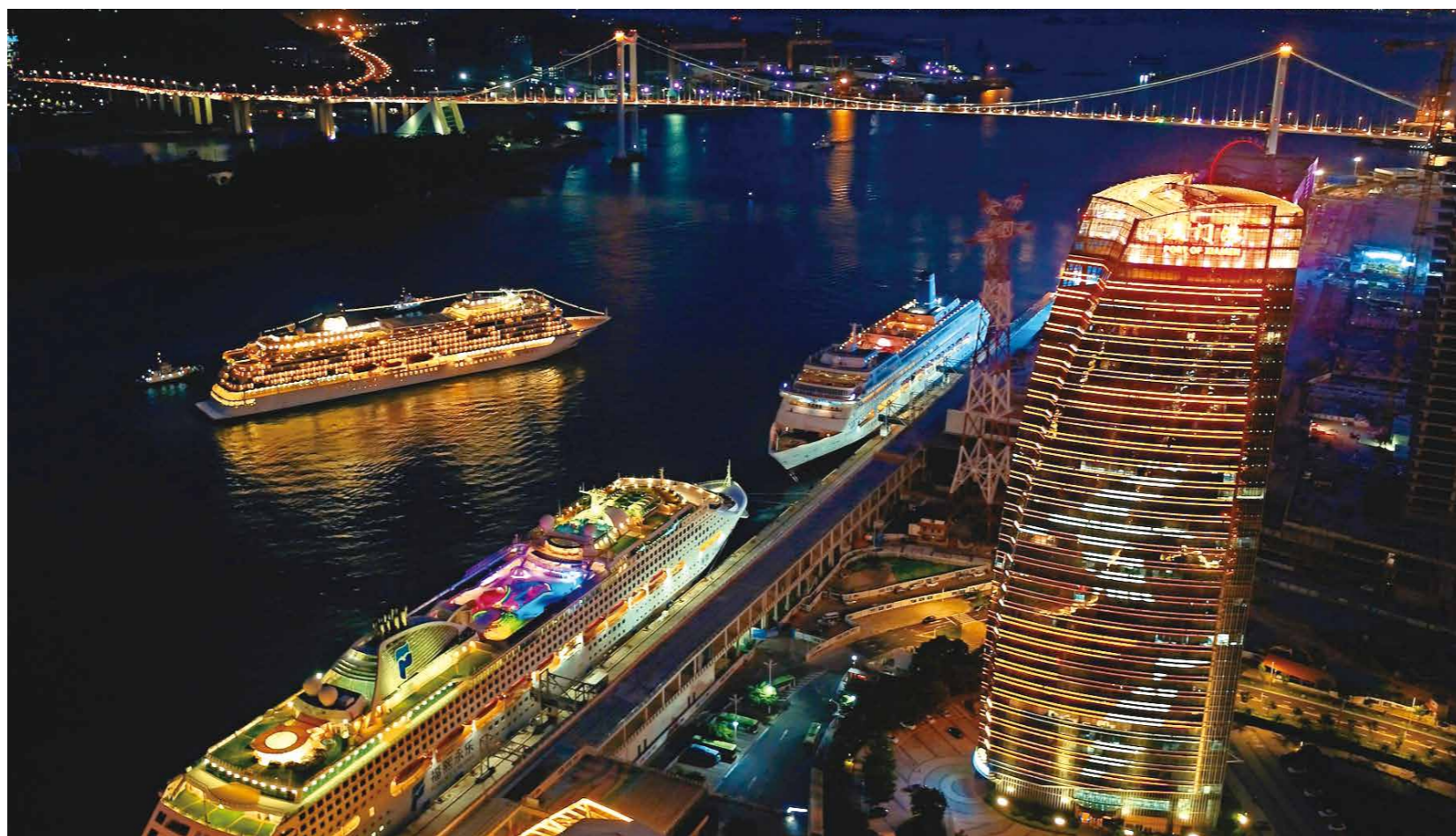
厦门国际邮轮母港推行邮轮岸基供电系统
