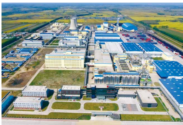
绥化象屿深加工产业园区
