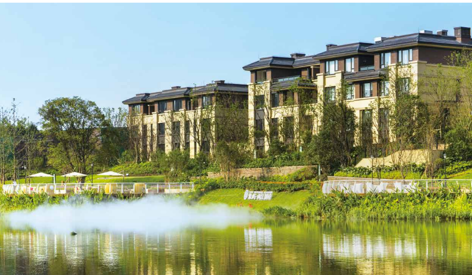
象屿两江项目开展翠微湖区水质治理
